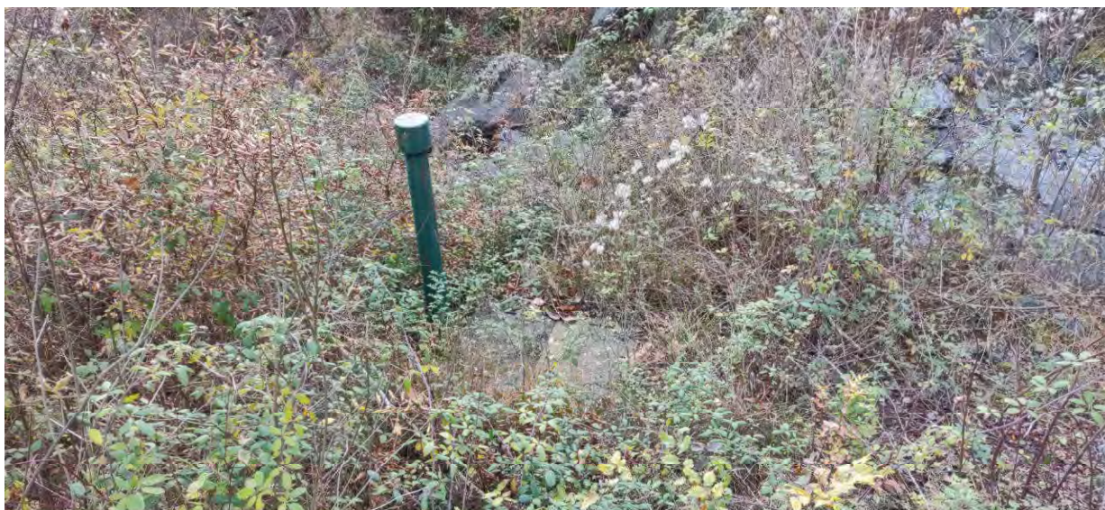
VISTA 12 - TUBAZIONE DI ESALAZIONE RETE IDRICA ESISTENTE CON POZZETTO
