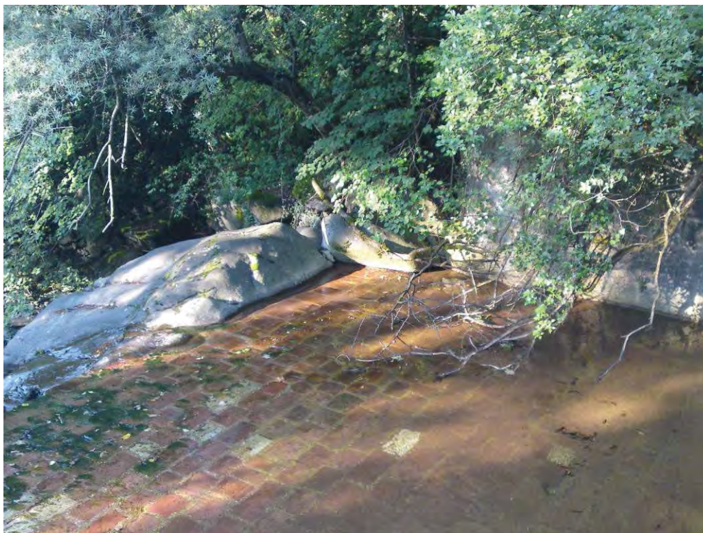
VISTA 3 – RIO SORINO TRONCO ARTIFICIALE
