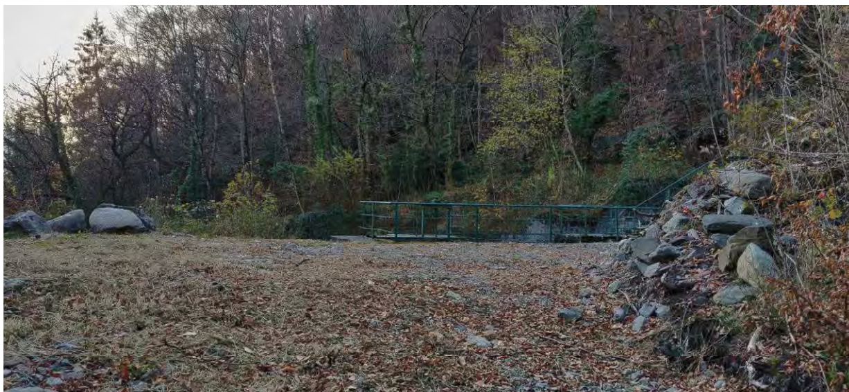
VISTA 11 – AREA ADIACENTE ALL'ORGANO DI PRESA ESISTENTE
