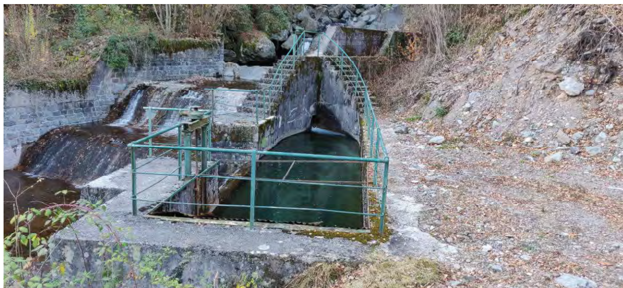
VISTA 4 – VASCA DI ACCUMOLO ACQUE ESISTENTE
