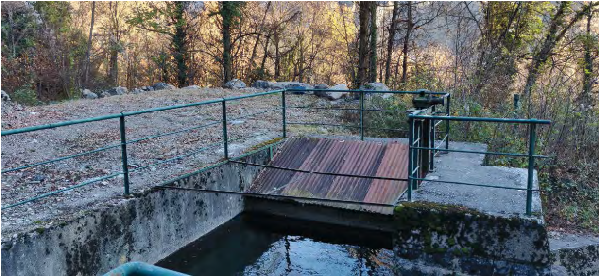
VISTA 5 – VASCA ACCUMOLO ACQUE ESISTENTE CON PARATOIA DI REGOLAZIONE, TETTOIA E GRIGLIA PER FILTRAGGIO ACQUE
