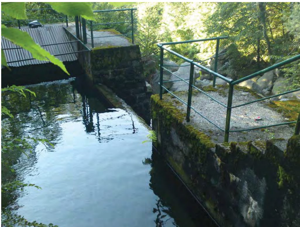
VISTA 6 – VASCA ACCUMOLO ACQUE ESISTENTE CON SOGLIA DI SFIORO
