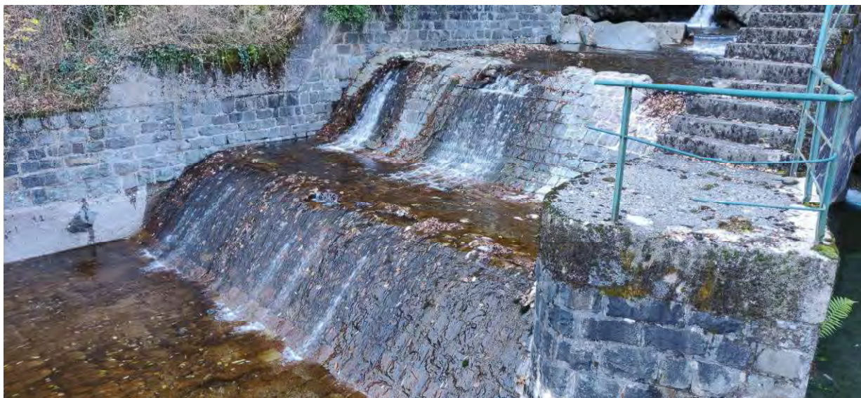
VISTA 1 – RIO SORINO TRONCO ARTIFICIALE CON PRIMA E SECONDA RAMPA
