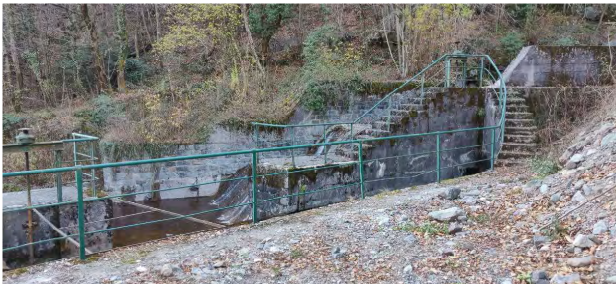
VISTA 7 – VISTA LATERALE ORGANO DI PRESA ESISTENTE
