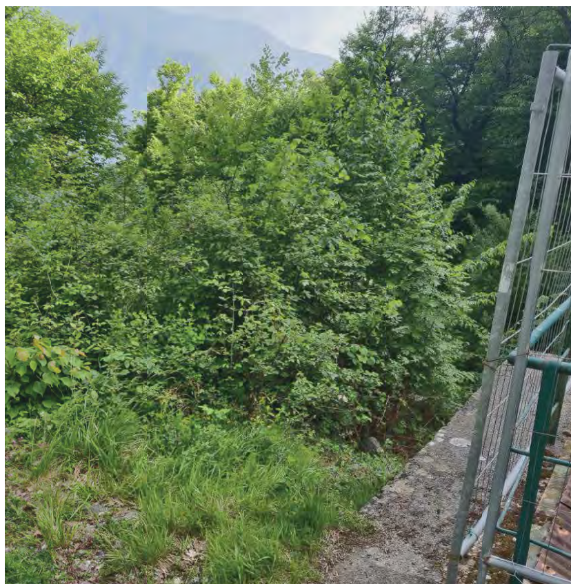
VISTA 4 - SCARPATA LATERALE ADIACENTE ALL'ORGANO DI PRESA
